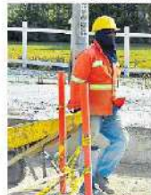
Se reinician unos trabajos públicos.
